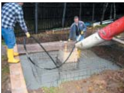
Das Fundament für die neue Vogelstange
