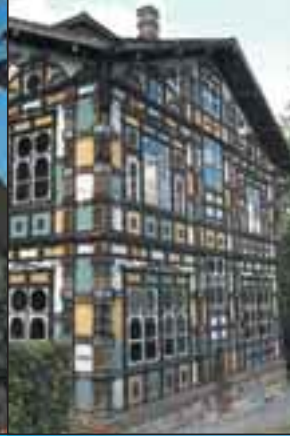
Das Junkerhaus an der Hamelner Straße
